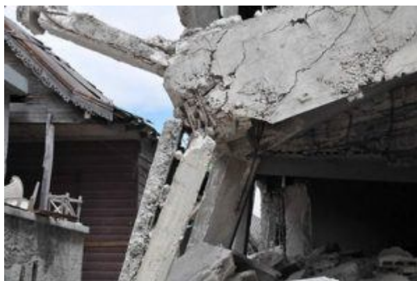
(شکل ۹) نمونه‌ای از شکست نهایی یک اتصال
